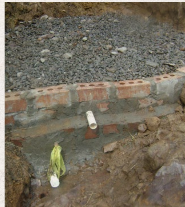
Preenchimento com brita. Fonte: Prefeitura de Caxias do Sul/RS, 2016
