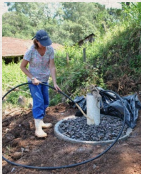
Preenchimento com brita. Fonte: Prefeitura de Caxias do Sul/RS, 2016.
