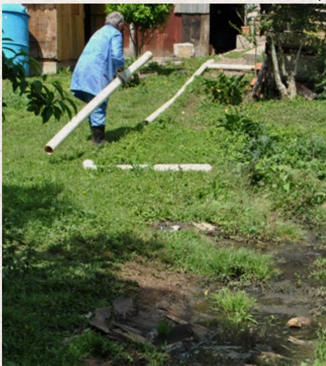
Instalação Fossa. Fonte: Prefeitura de Caxias do Sul/RS, 2016.
