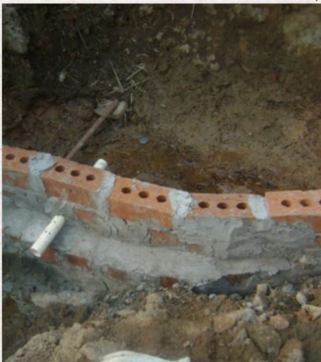
Instalação da mureta. Fonte: Prefeitura de Caxias do Sul/RS, 2016.
