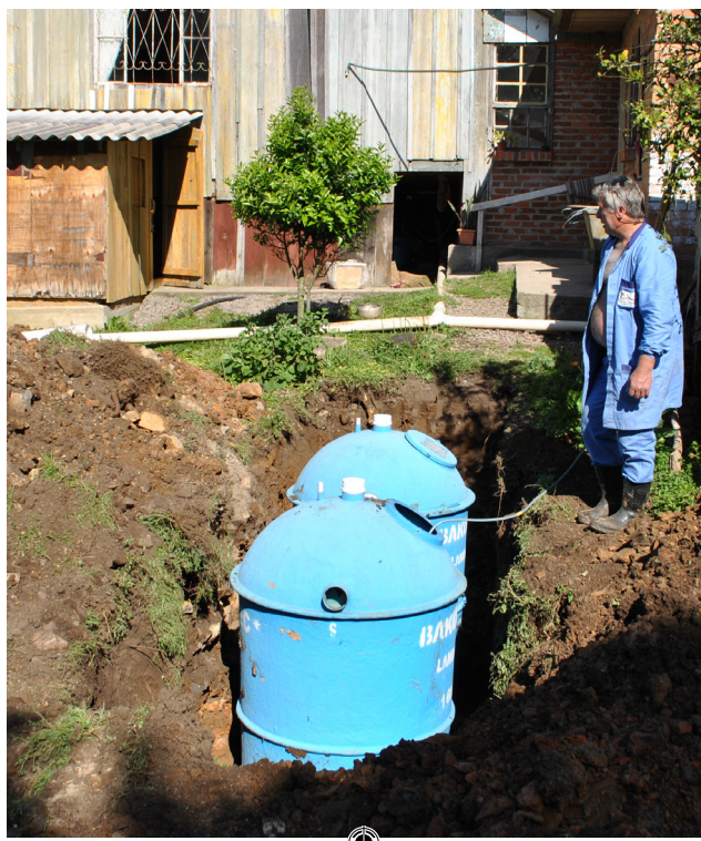
Instalação Fossa. Fonte: Prefeitura de Caxias do Sul/RS, 2016.
