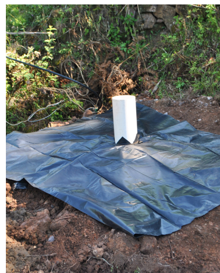
Preenchimento com terra. Fonte: Prefeitura de Caxias do Sul/RS, 2016.
