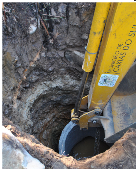
Tubos de concreto. Fonte: Prefeitura de Caxias do Sul/RS, 2016.
