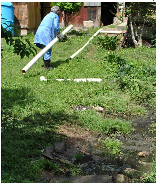
Instalação Fossa. Fonte: Prefeitura de Caxias do Sul/RS, 2016.
