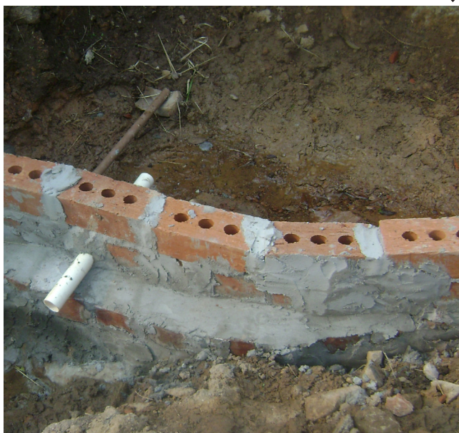
Instalação da mureta. Fonte: Prefeitura de Caxias do Sul/RS, 2016.
