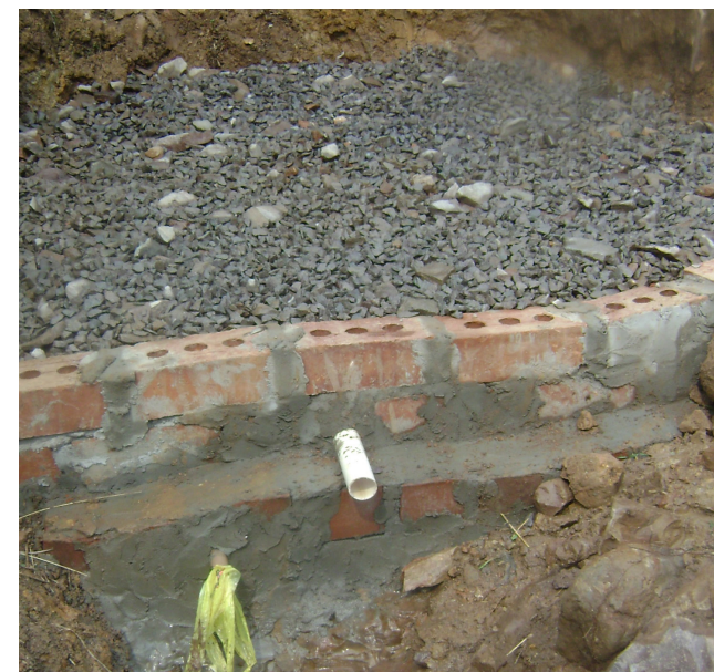
Preenchimento com brita. Fonte: Prefeitura de Caxias do Sul/RS, 2016.
