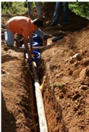
O técnico Vagno fazendo a instalação da fossa séptica econômica
