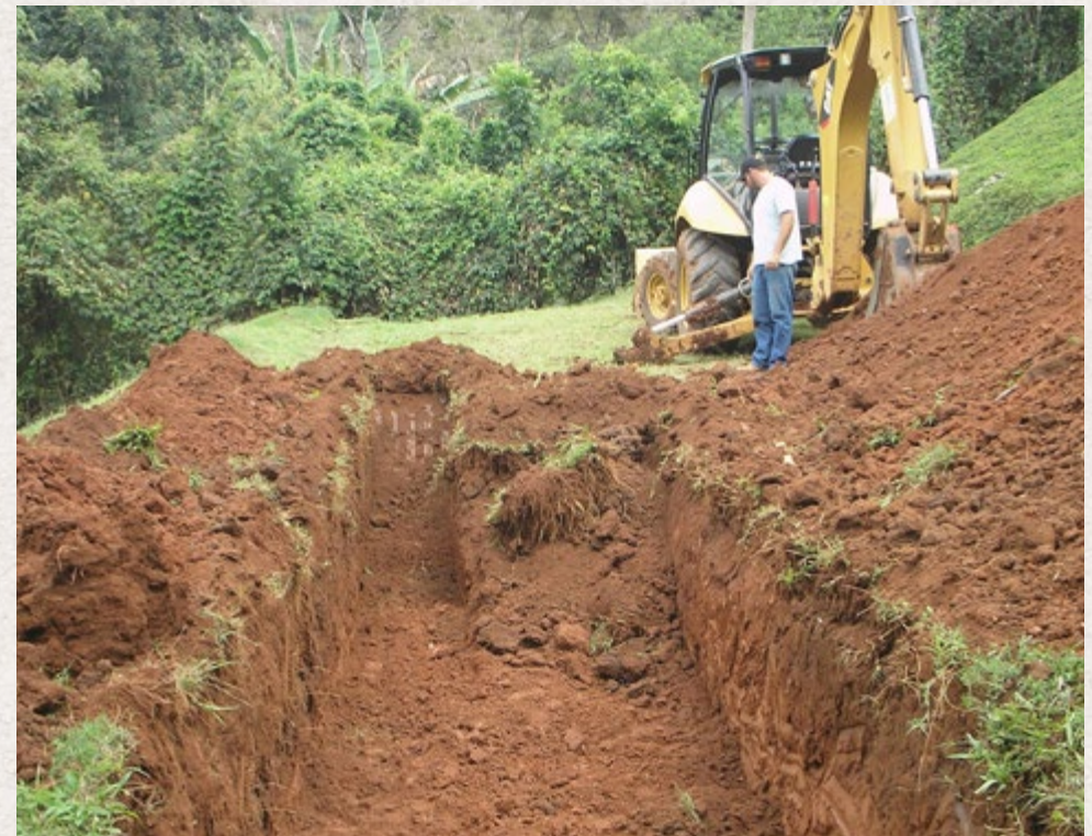
Abertura da fossa TEvap utilizando máquina. Fonte: Emater/MG, 2016.
