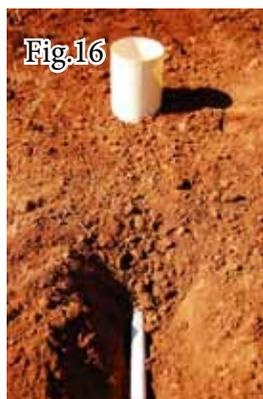
25 x 1/2" para instalação dos aspersores de baixa pressão (em torno de 200 kPa de pressão ou cerca de 20 m de carga manométrica) baixa vazão (cerca de 540 L/h) determinada por bocal único em torno de 3,2 mm de diâmetro. Observar que para o último aspersor, o tê deve ser substituído por um joelho de 90°.
